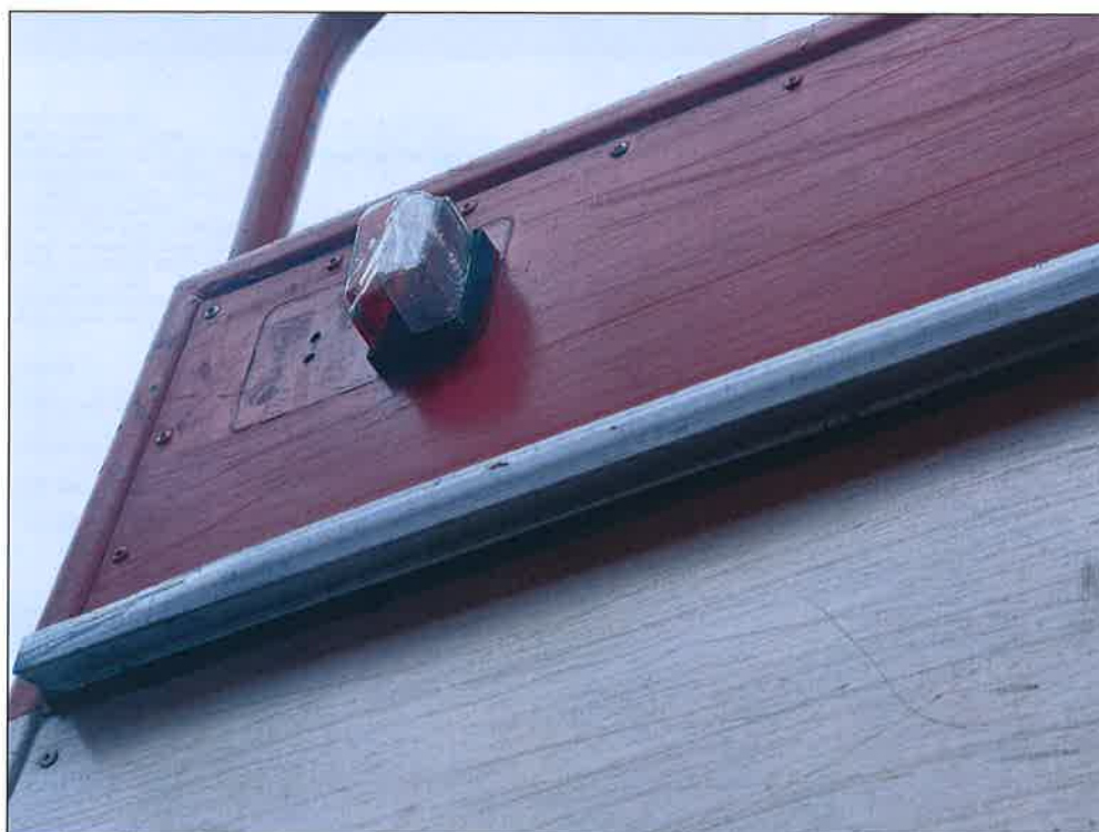
Poškodenie obrysového svetidla
